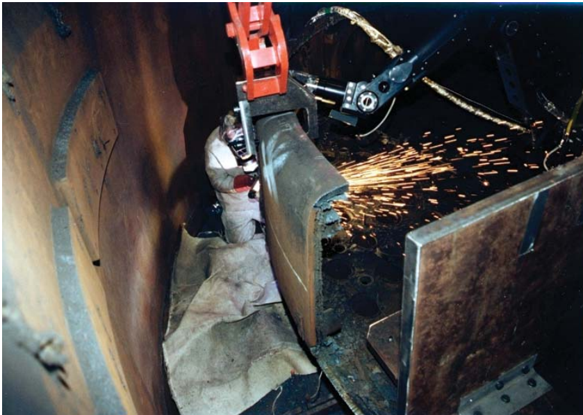
図7：ホットボックス側壁板の手持ち式プラズマ切断
