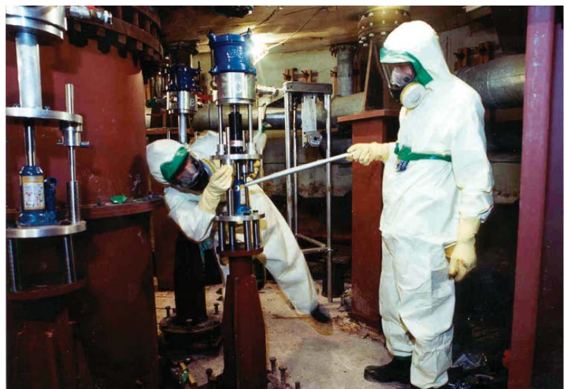
図8：技師が、グラウト接続パイプを原子炉下の地下室にあるループ管下端に取り付けている。
