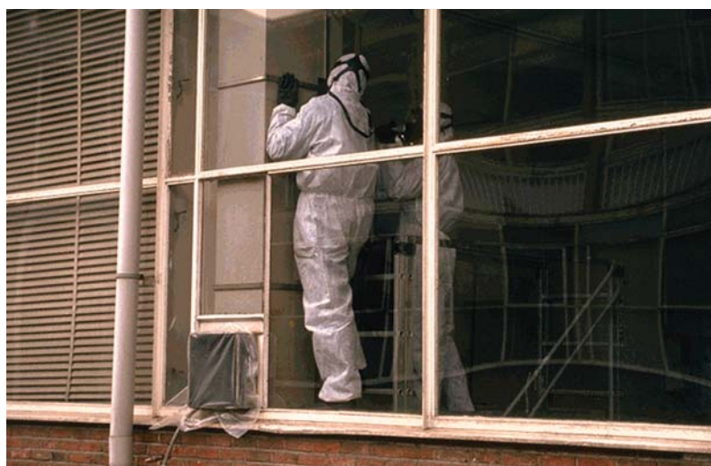
図2：ベルギーのモル研究所における換気配管の解体。
