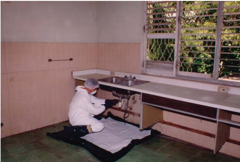
図1：ドミニカ共和国の小線源照射療法科における汚染された流し台の解体
